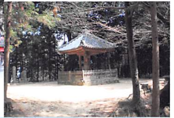
傘堂 伝「左甚五郎作」 1辺42cmの方柱1本の上に 1辺1間(1.8m)で方形屋根
